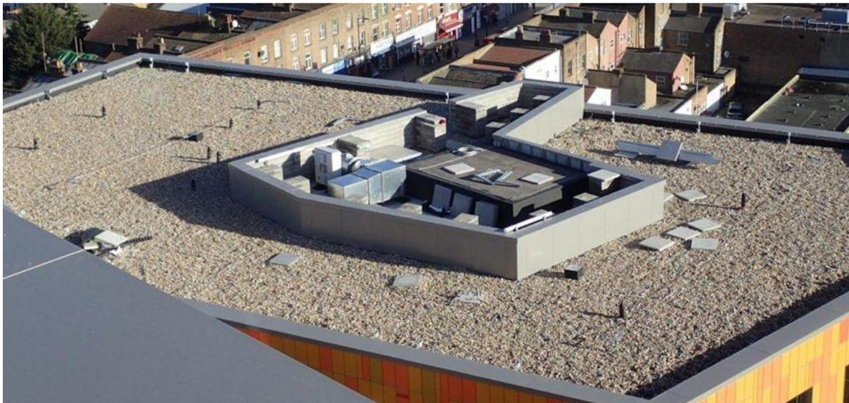
Fig. 5: Biodiverse roof finish
