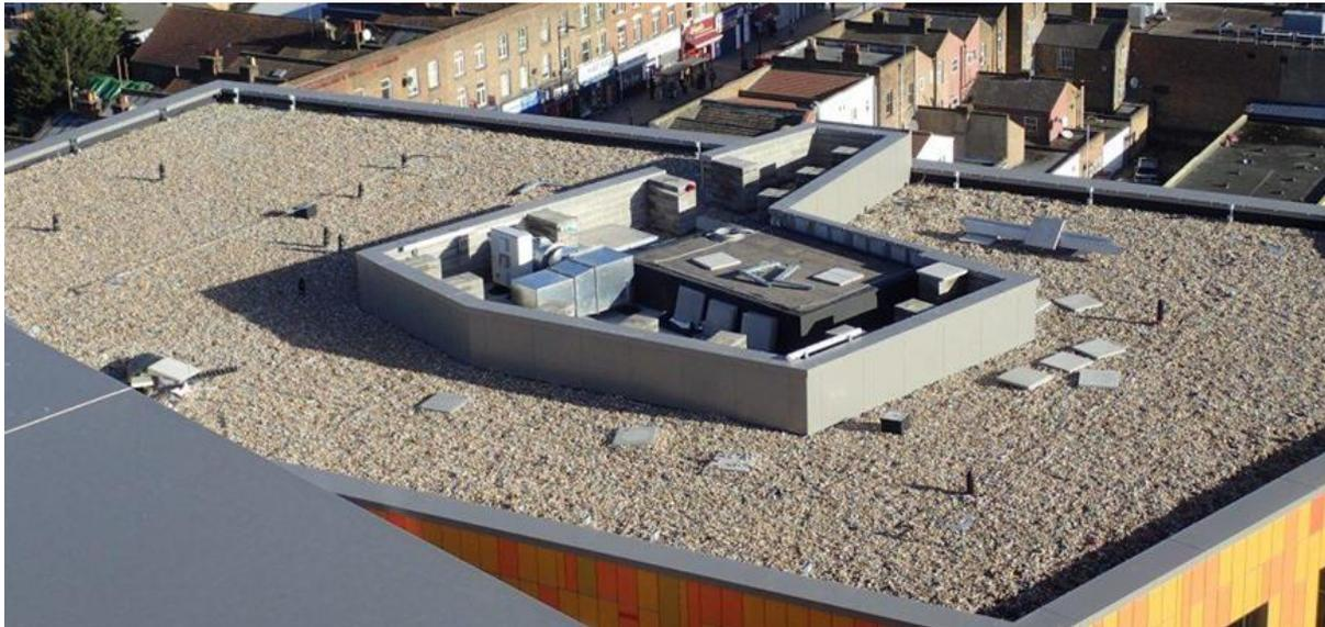
Fig. 5: Biodiverse roof finish
