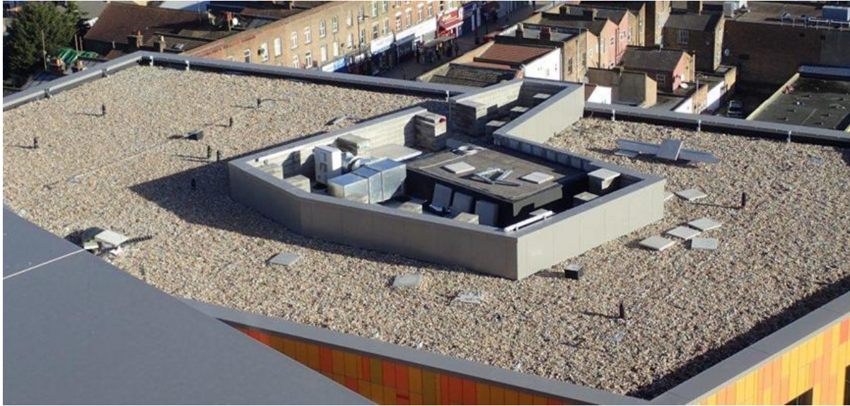
Fig. 5: Biodiverse roof finish
