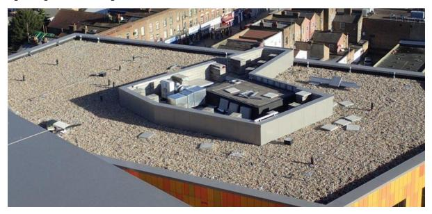
Fig. 5: Biodiverse roof finish
